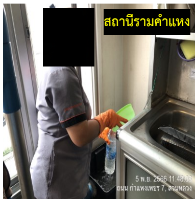
รูปที่ 2-13 แม่บ้านตักไขมันออกจาก Grease Trap
