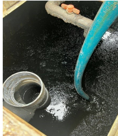
รูปที่ 2-30 การทำความสะอาดระบบบำบัดน้ำเสีย
